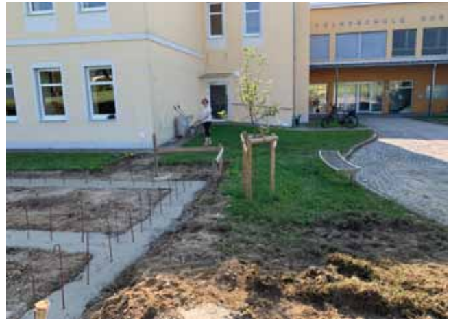
Die Streifenfundamente für die Containerklasse sind fertig
